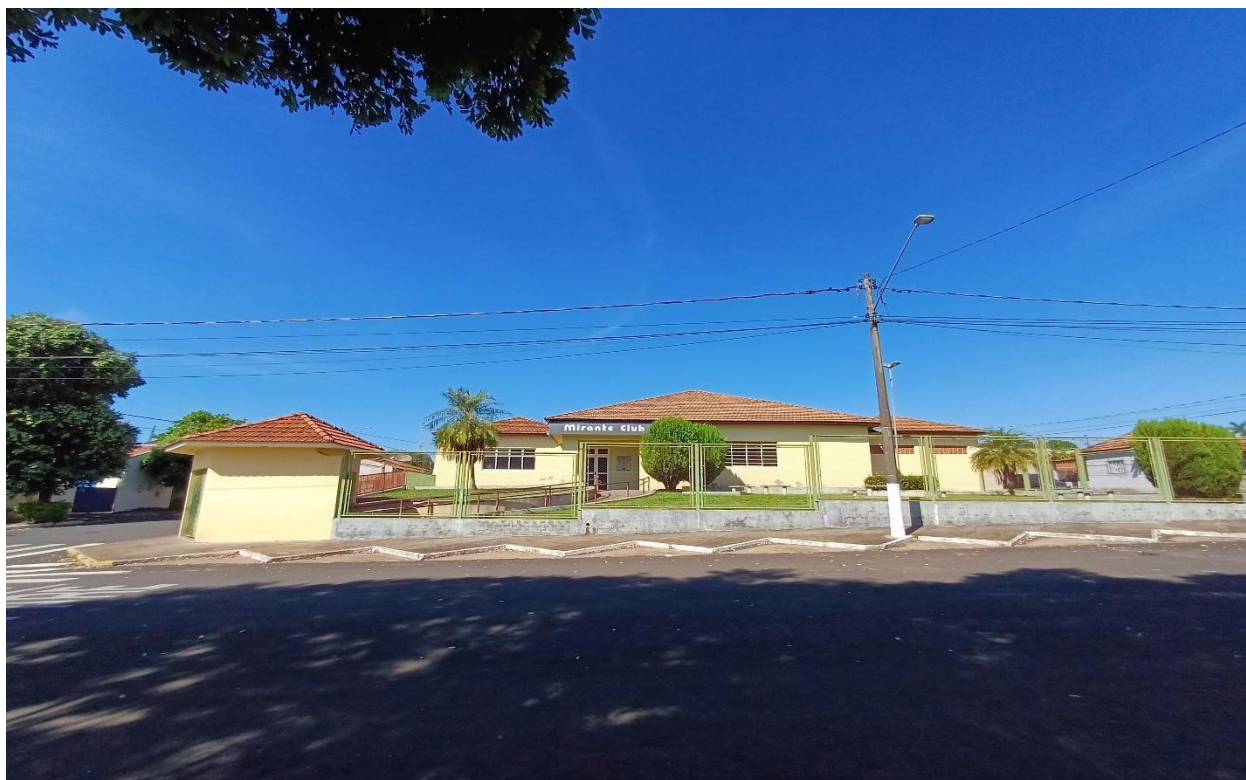
Fachada Mirante Club
