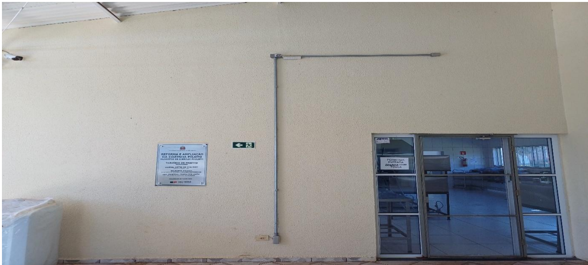
Fachada Cozinha Piloto
