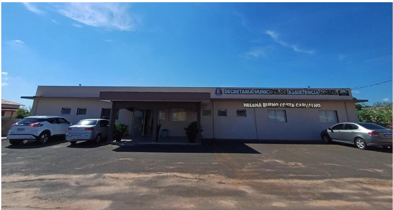
Fachada Secretaria Municipal de Assistência Social
