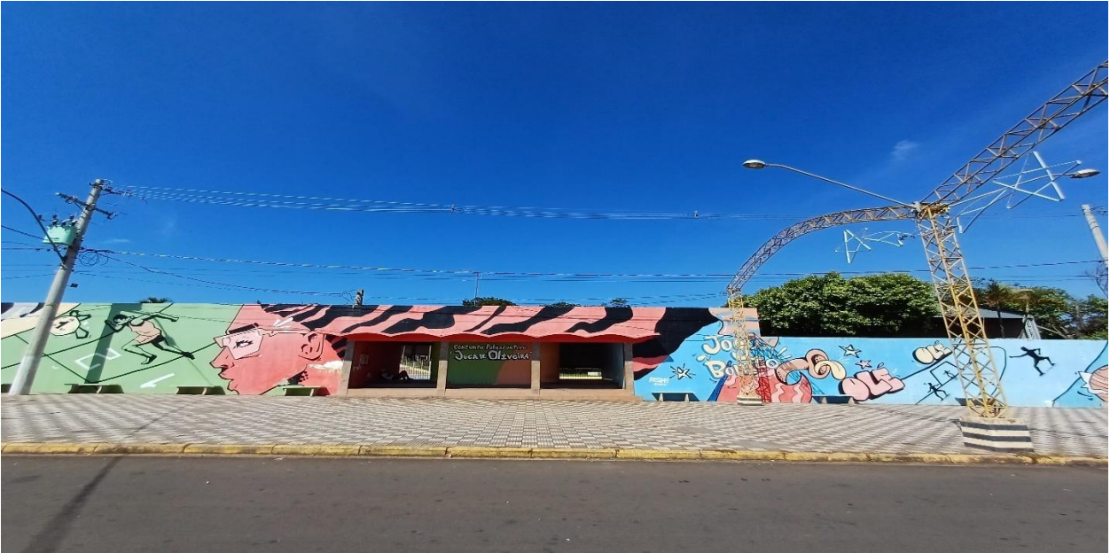
Calçada da Piscina
